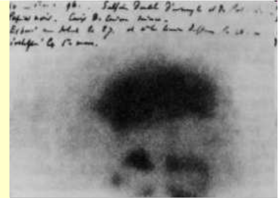
Original von Becquerel: Durch Uranmineral geschwärmte Fotoplatte.
